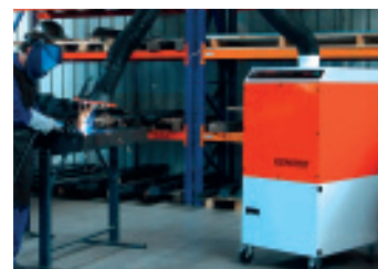
Plaatselijke afzuiging lasrook.
