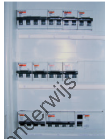
Zekeringen zijn beveiligingen tegen overbelasting of bij kortsluiting
